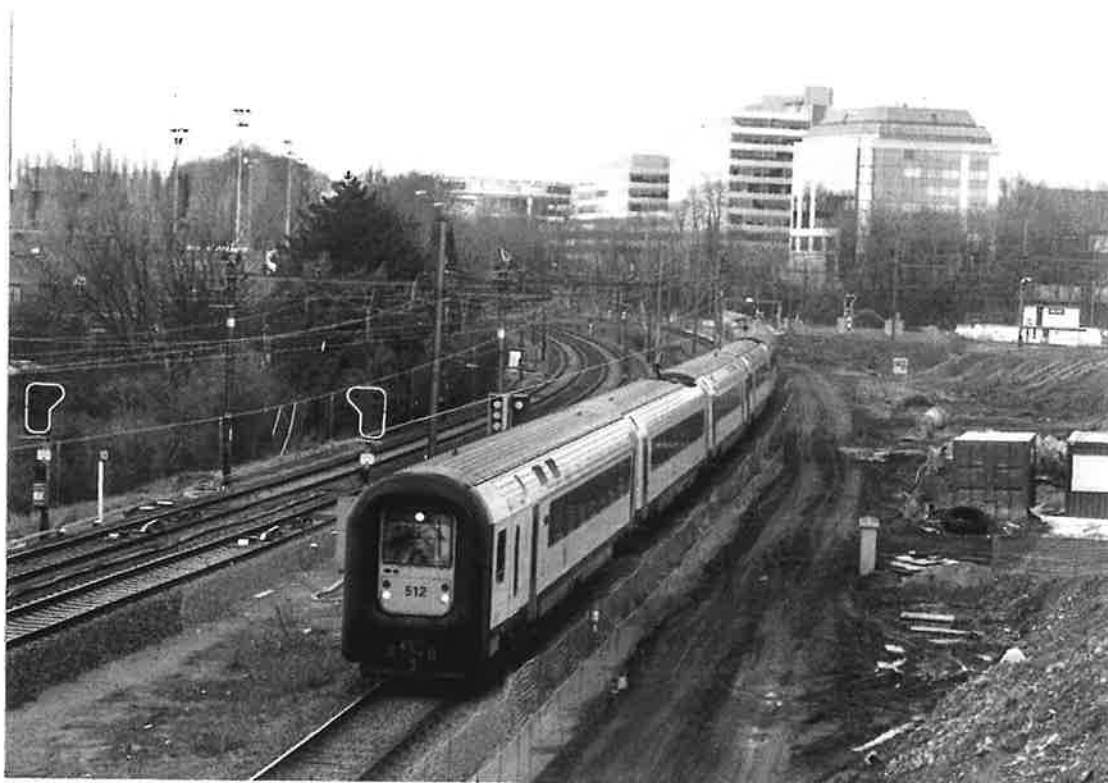
Les travaux d'aménagement des lignes 26 et 161 en vue de l'exploitation du RER bruxellois, entraînent d'importants travaux dans la zone de Watermael et dans les dépendances de la gare d'Etterbeek. Vue du chantier et d'une AM circulant vers Watermael sur la voie de débord de la ligne 161 le 26 février
